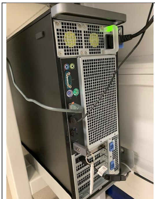
Figura 3 – Collegamento di rete al banco di misura
